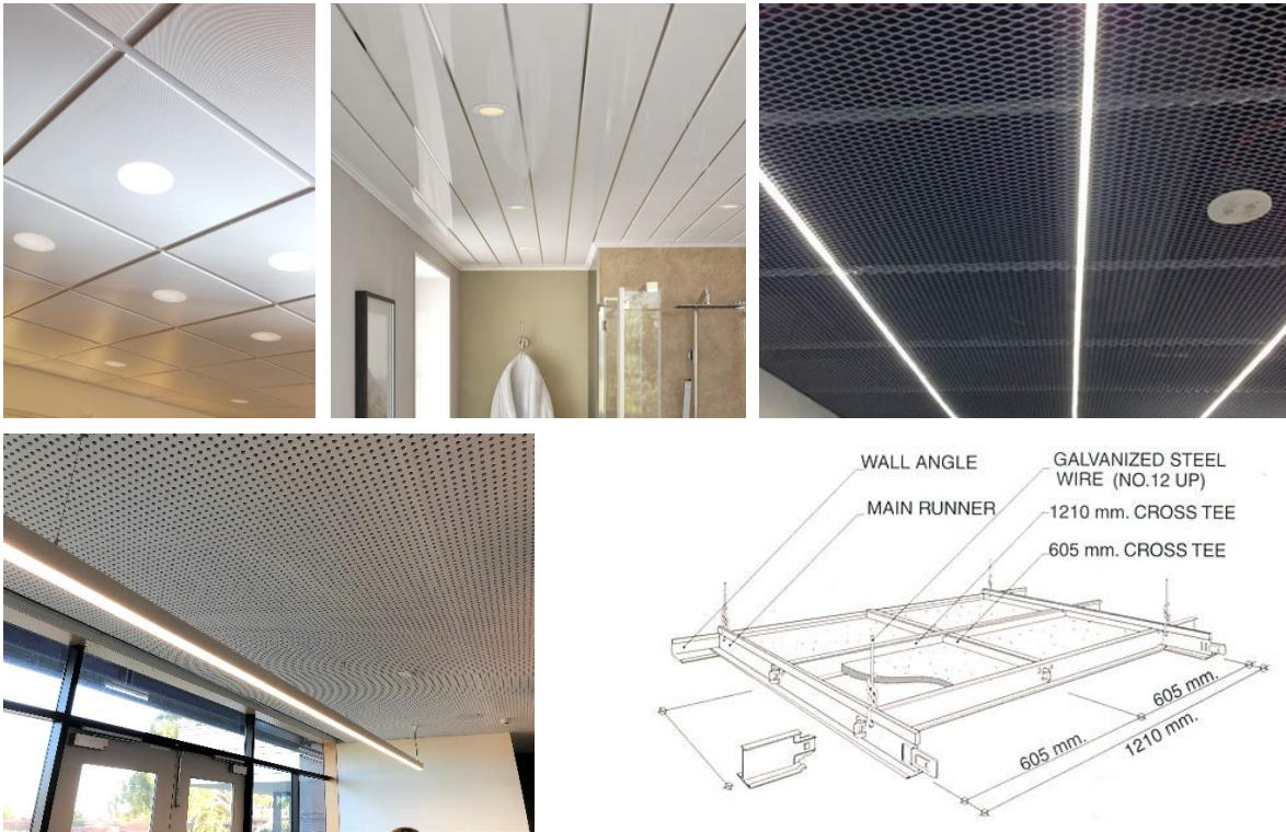
شكل رقم 13 يوضح الأنواع المختلفة من الأسقف (1 البلاطات - 2 الشرائط - 3 شبكات الحديد - 4 السقف المثقوب - 5 إحدى طرق تعليق السقف)
